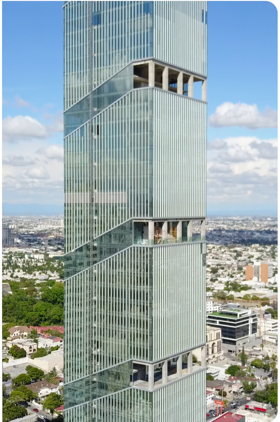
La edificación sustentable, la protección del medio ambiente y el manejo de los costos de energía a largo plazo, son planteamientos vitales para los diseñadores de edificios contemporáneos, como es para el caso de la Torre T.O.P
