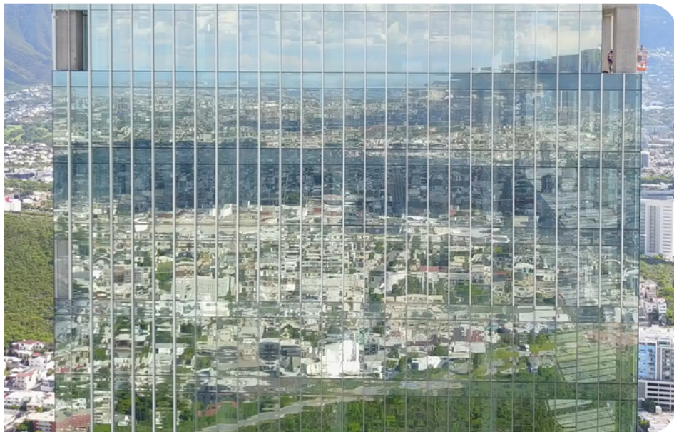
Solarban® R100 en uno de los cristales arquitectónicos de mejor rendimiento en el mercado ya que su coeficiente de ganancia de luz solar (LSG) de 1.83 es hasta un 29% superior al de los vidrios de baja emisividad reflejantes de la competencia.
